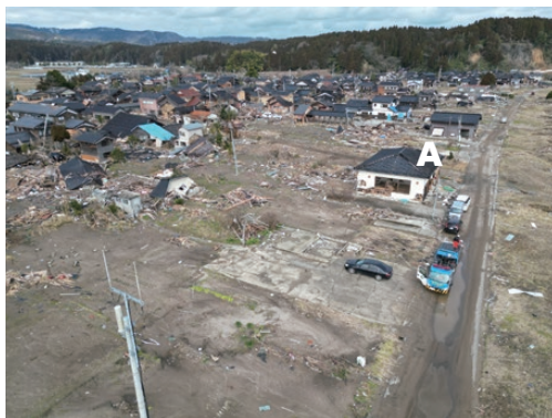
写真3 珠洲市宝立町春日野付近。2024年2月9日撮影。写真中の建物Aが図7中の建物A
