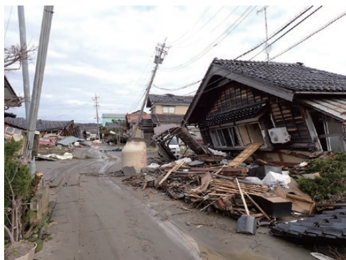
写真12 珠洲市宝立町鶴飼の津波到達範囲の被害状況。2024年2月9日撮影
