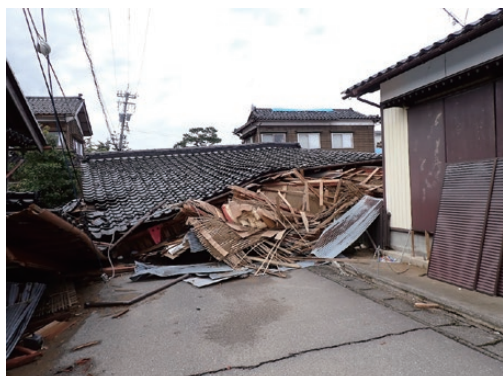
写真6 珠洲市宝立町鶴飼付近の倒壊した家屋で閉塞された車道。2024年2月9日撮影
