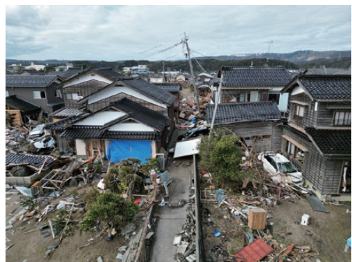
写真5 珠洲市宝立町鵜飼付近の倒壊した家屋などで閉塞された小路。2024年2月9日撮影
