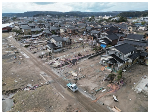
写真10 津波からの避難途中で津波に流され人的被害が生じたとみられる、珠洲市宝立町鶴飼付近。2024年2月9日撮影
