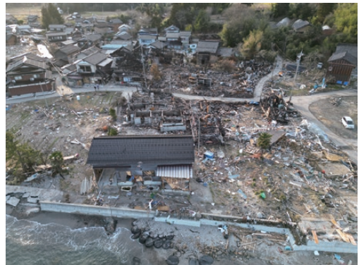
写真7 能登町白丸付近の火災で焼失した建物。2024年2月9日撮影
