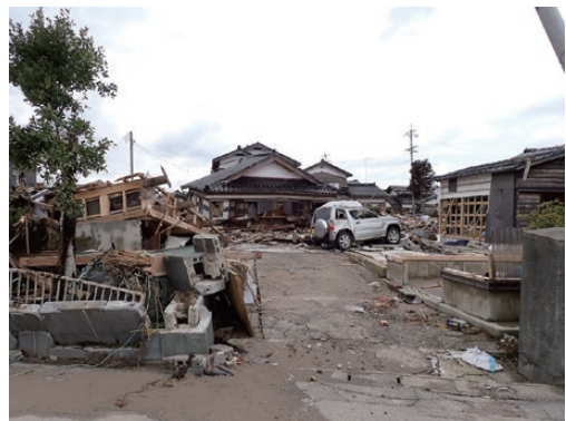
写真4 珠洲市宝立町鵜飼付近の津波で流失したとみられる建物。2024年2月9日撮影
