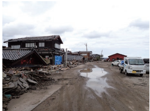
写真11 珠洲市宝立町鶴飼の海岸付近の被害状況。2024年2月9日撮影
