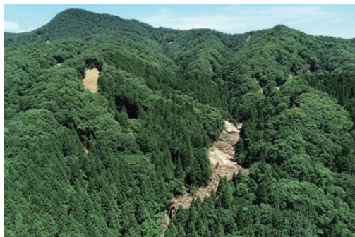
図20 大沢川の砂防堰堤に堆積した流木の状況 (2022年8月5日撮影)
