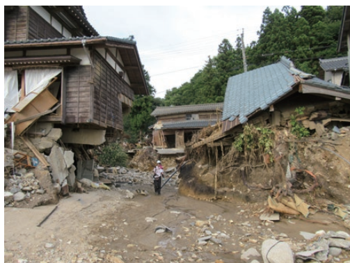
図22 大沢川から溢れ出た水流によって深く洗掘された箇所（位置は図16Cに示す） （2022年8月8日撮影）
