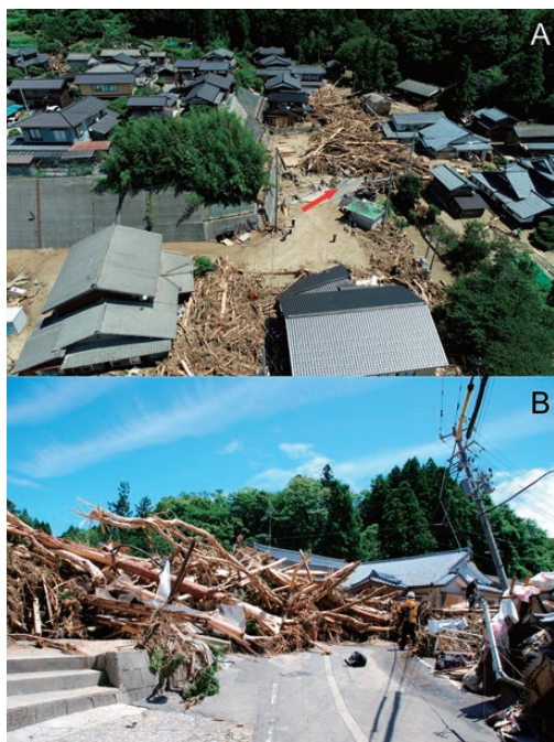
図21 小岩内集落内の大沢川河道上とその周辺に堆積した流木 (2022年8月5日撮影) Bの撮影位置と方向を赤矢印でAに示す。
