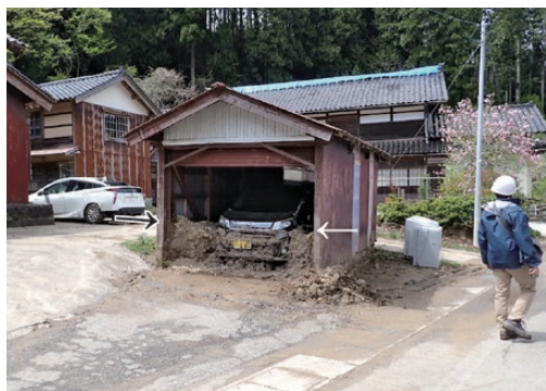
写真3 市ノ瀬町の地点g3(図2)で見られる土石流痕跡(2024年4月25日撮影)。土石流は既に取り除かれている。矢印は、土石流痕跡のレベルを示す。
