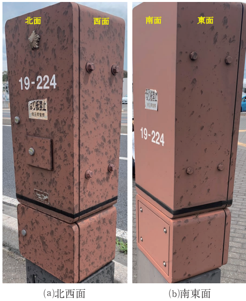
図9 2022年6月2日の降ひょうによる道路交通機器の被害写真(周辺住民へのヒアリングにより、ひょうの痕跡が6月2日の降ひょうにより生じたことを確認。(a)北西面のほうが(b)南東面よりも、ひょうが当たったとみられる痕跡が多い。埼玉県本庄市, 2022年7月6日著者撮影)
