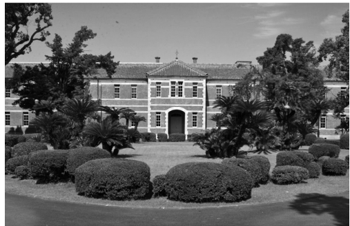
熊本 轟橋 石垣 住宅 樹木 段面 柱 庭木 破損 熊本城 築 熊本大学 外観 鳥製 落下 内観 国指定重要文化財 屋根瓦 傾き 城内樹木
