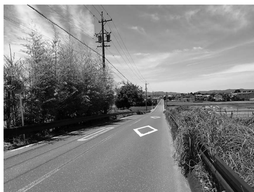
写真3 豊橋市下条東町の被災場所付近。2023年6月4日午山撮影
