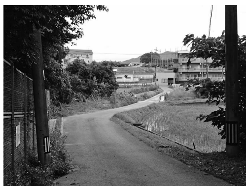
写真14 久留米市藤山町の被災場所付近。2023年7月15日牛山撮影
